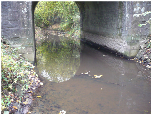
ruisseau de la Vallée sous la route départementale (RD) 33
